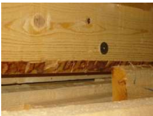
Imagen 1 – Ripio al borde de la tabla no está reglamentado.
